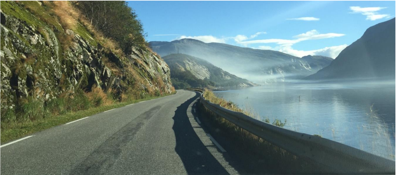
Billedtekst: FV 17 mellom Ørnes og Gomfjord holder en svært lav standard og er rasutsatt (Foto: Jens Kyed)
