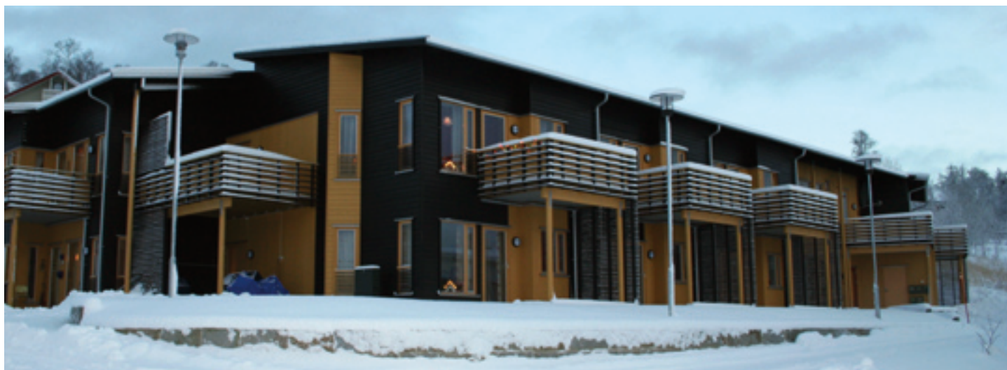
Omsorgsboliger Hamarøy Kommune.
